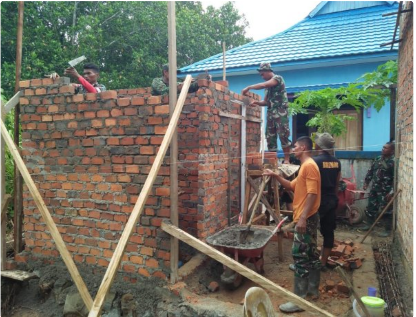
Pasiter Tinjau Proses Pekerjaan Sasaran Tambahan TMMD ke-118 Pembangunan MCK Gereja
