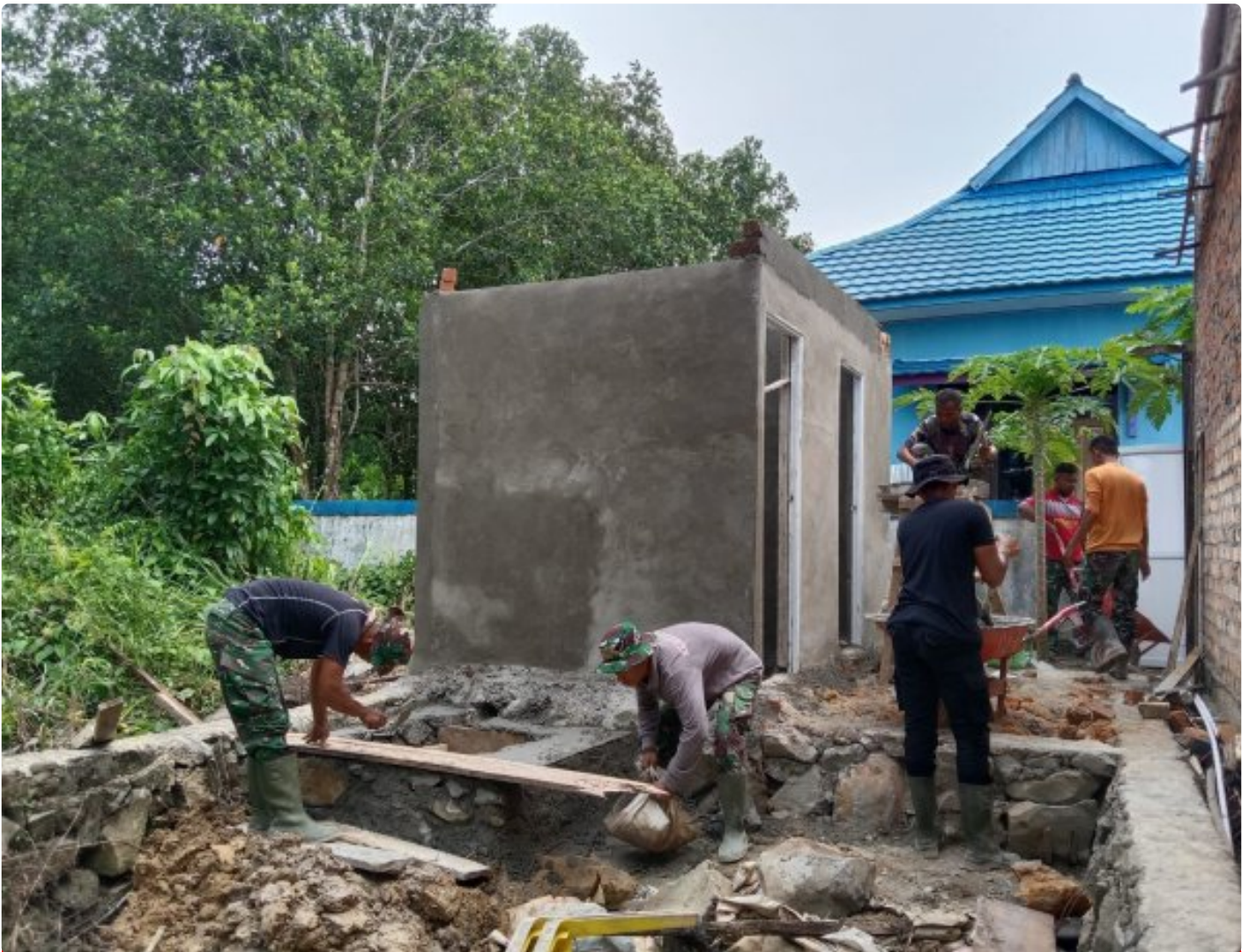
Satgas TMMD ke- 118 Wiltas Kodim 0910/Malinau Progres Pembuatan Septic tank MCK Gereja
